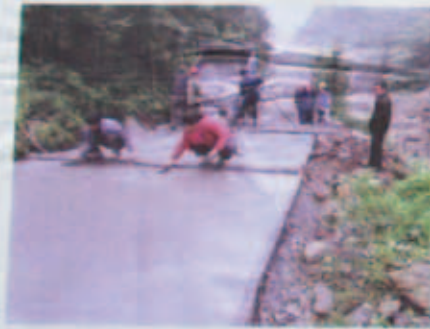
正在施工水泥路面
