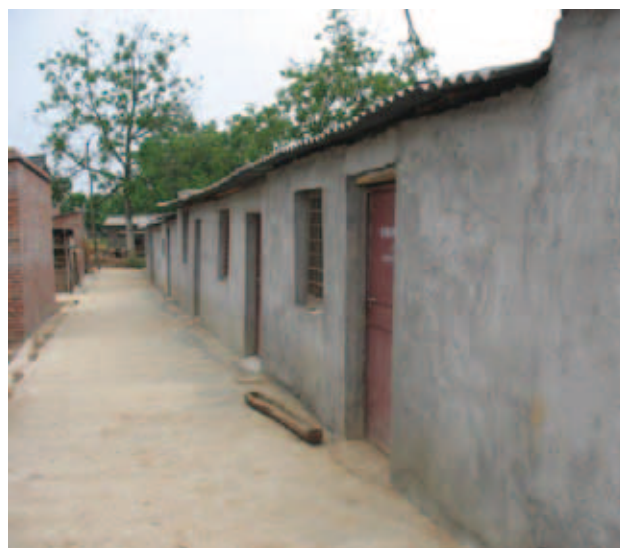
甘肃成县索池乡寨子村建成的一池三改不仅方便了群众，还提供了增收渠道（养殖业）
