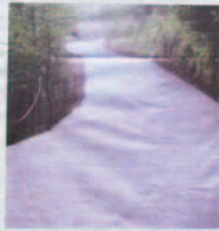
已完工水泥路
