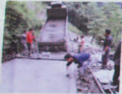
正在施工水泥路面
