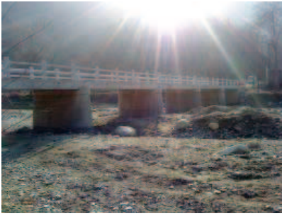
完工后的罗家嘴大桥全貌
