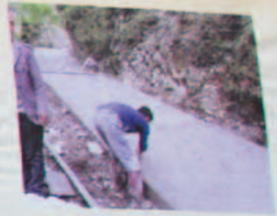
新架水泥路面
